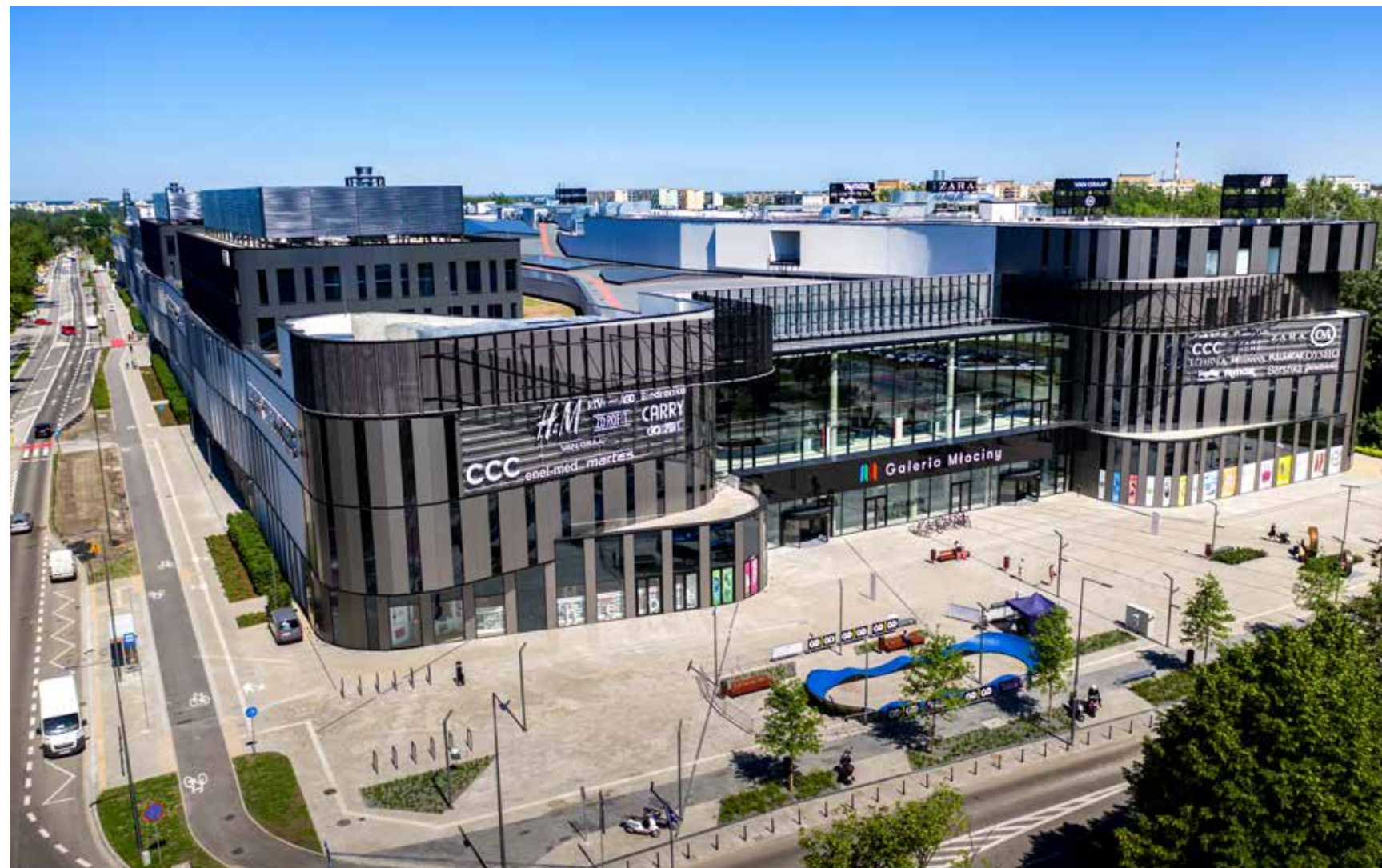
CENTRUM HANDLOWO-USŁUGOWO-ROZRYWKOWE GALERIA MŁOCINY
